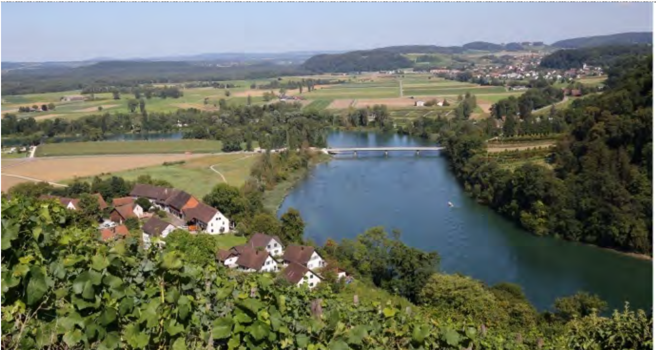
Aussicht auf den Rhein in Rüdlingen, renovierte Rheinbrücke 2024
