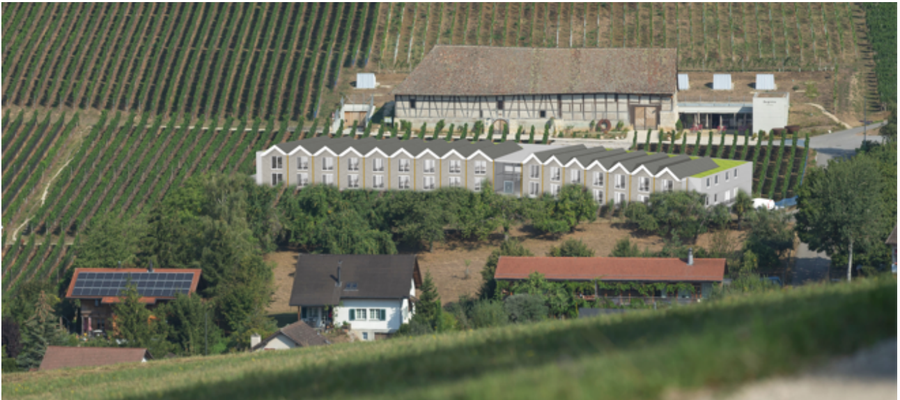
Blick auf die Hotelanlage von Punkt 504 im «Himmelrich»
