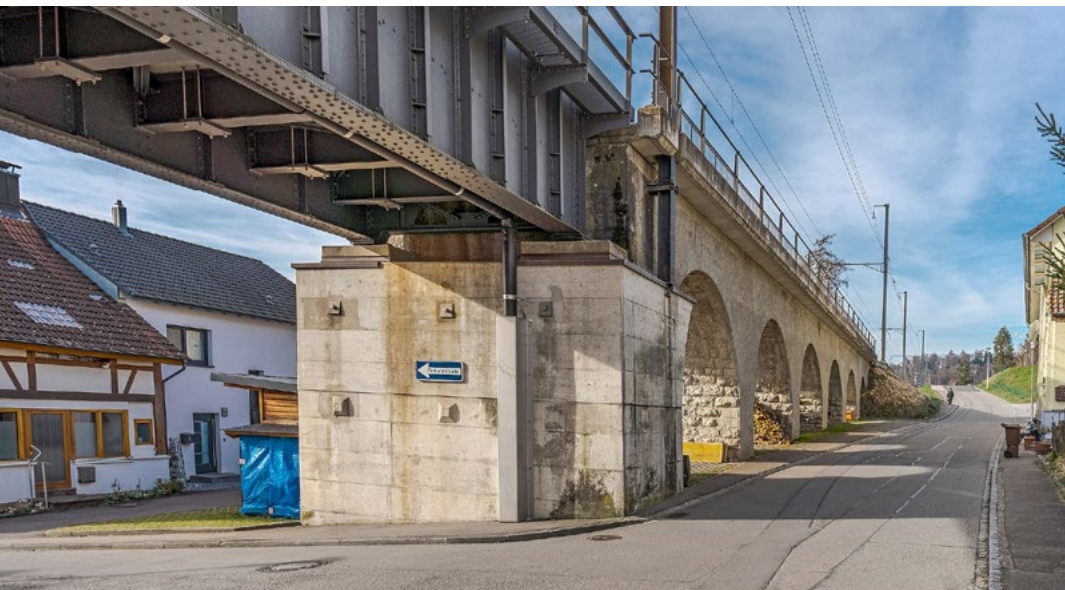
Dorfviadukt in Lottstetten
