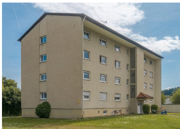
Dieser Wohnblock ist im Originalzustand erhalten.
