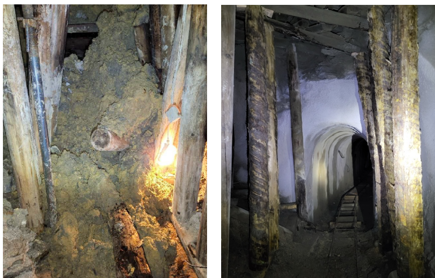
Abbildung 3: Gipsstollen Schleithcim vor (links, 2023) und nach der Sanierung (rechts, 2024)
