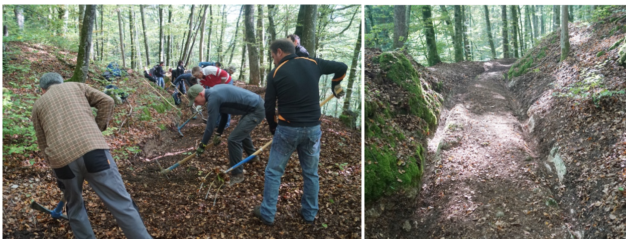
Abbildung 8: Freilegung historischer Verkehrsweg in Guntmadingen, Beringen, 2018
