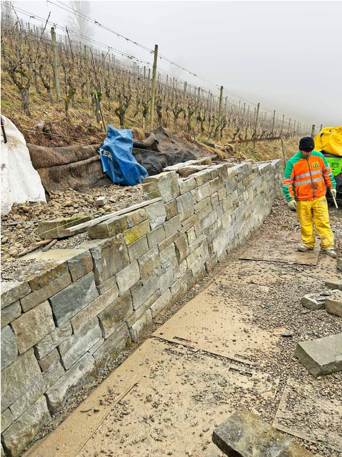
Sanierung einer Trockensteinmauer in den Hallauer Rebbergen
